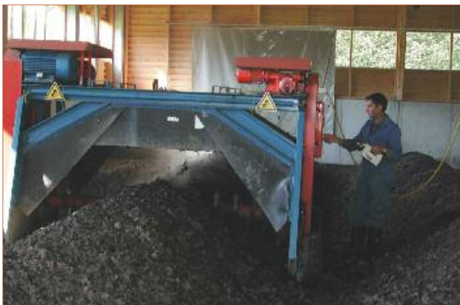
Composting plant — Allgemeine Unfallversicherungsanstalt, Austria
